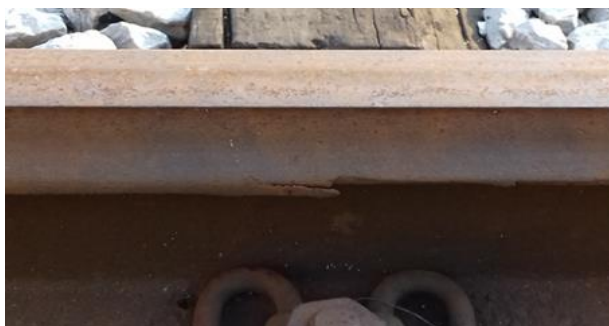
Slika 1. Istrošena tračnica
