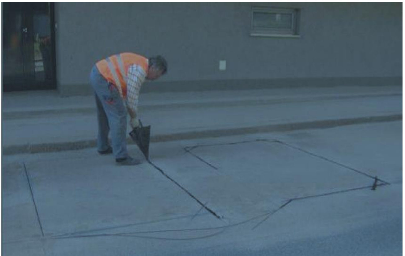
Slika 4: Induktivna zanka v cestišču.
