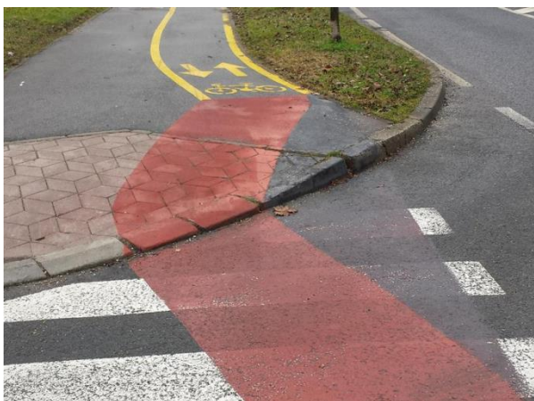
Slika 3. Preusmjerenje dvosmjerne biciklističke staze s neupuštenog rubnjaka na upušteni dio
