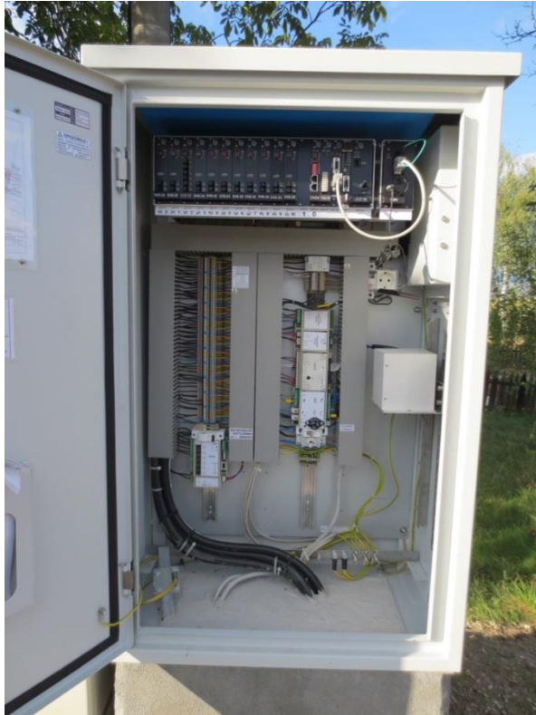
Slika 6: Semafovska naprava z induktivno zanko
