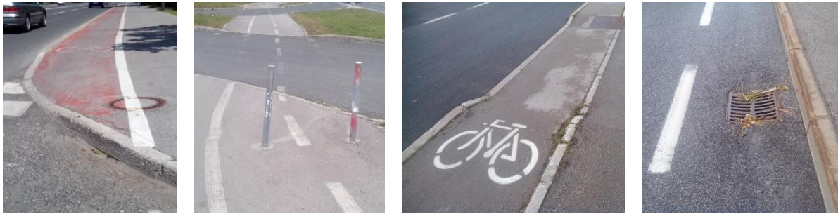
Slika 4: Vir: Lastni, nevarni ali neprimerni detajli na kolesarski infrastrukturi v Sloveniji.
